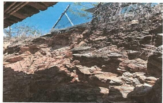
Foto 4: se realizara muro de contención en la parte baja de los baños ya que se encuentra en mala condiciones.
