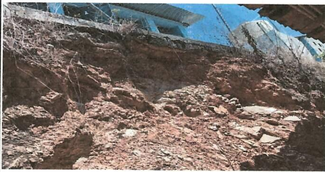
Foto 3: se realiza muro de contencion en la parte baja de los baños y que se esta cayendo la tierra.
