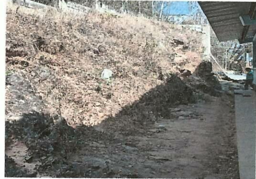
Foto 2: reparacion de muro de contencion en la parte trasera del establecimiento debido a que esta en mala condiciones.
